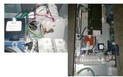
La mauvaise connexion du câble dans la borne a causé un échauffement et une rupture de la continuté. L'expertise de ROCWELL, nous permettra de savoir si cette rupture de connexion sur la puissance à un lien avec la perte de la commande du variateur.
